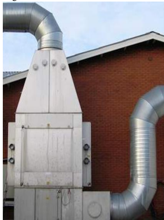
Figur 1 Et ikke-termisk plasma system fra APP
